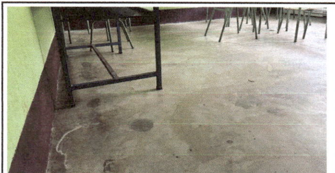
Foto 5: piso rústico del anexo de direccion del módulo 1. Se instalará piso cerámico
