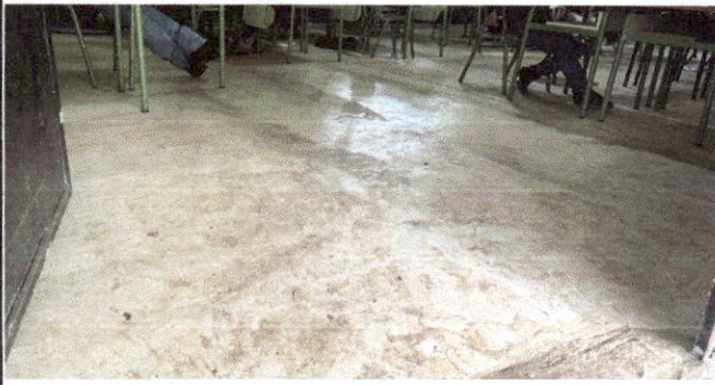
Foto 7: piso rústico del aula No.2 del módulo. 2 Se instalará piso cerámico
