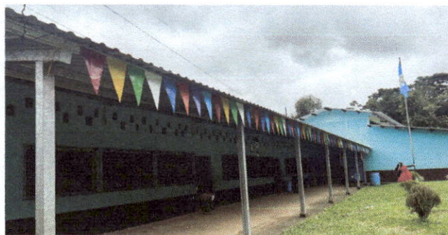
Foto13: se instalarán canales y bajadas de agua pluvial en módulo 2.
