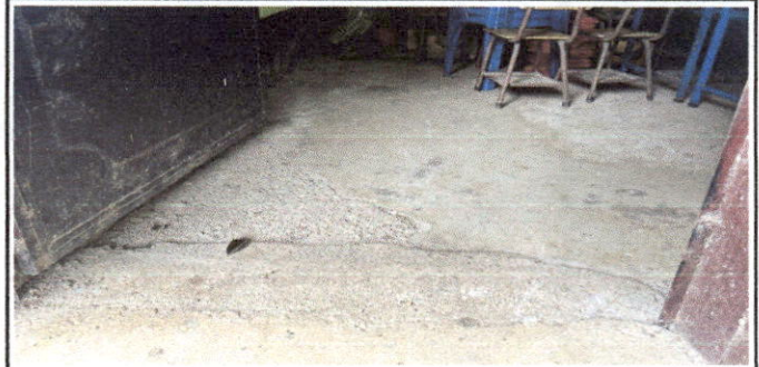
Foto 8: piso rústico del aula No.3 del módulo 2. Se instalará piso cerámico
