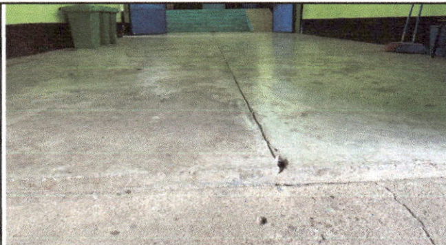
Foto 9: piso rústico del salón de usos múltiples del módulo 1. se instalará piso cerámico
