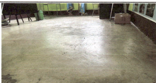
Foto 4: piso rústico de la dirección del modulo 1. Se instalará piso cerámico
