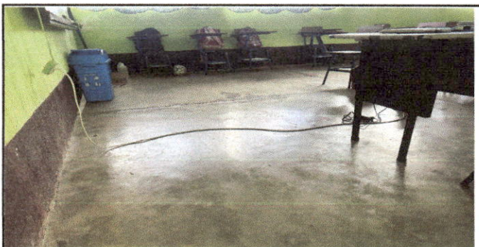
Foto 3: piso rústico del aula No.3 del módulo 1. Se instalará piso cerámico.
