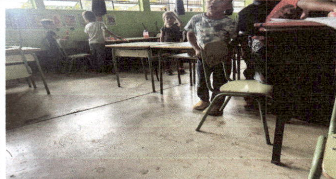
Foto 2: piso rústico del aula No.2 del módulo 1. Se instalará piso cerámico.
